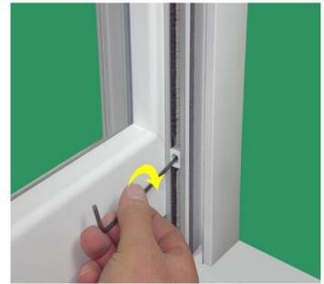
Schraube in IS-Riegel mit 4 mm Inbusschlüssel andrehen
