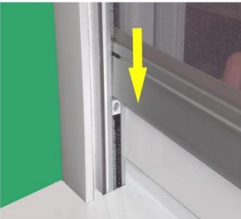
Gegenüberliegenden IS-Riegel mit Zugschiene runterschieben
