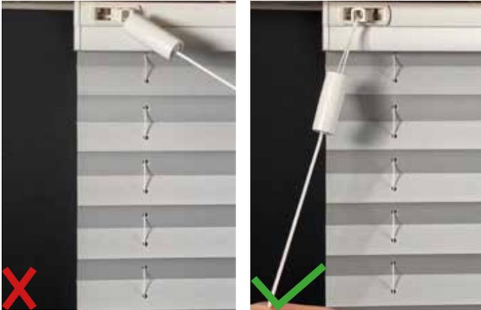
Oftmals kommt es bei unsachgemäßer Bedienung dazu, dass die Kindersicherung aufgeht. Meistens geschieht dies, wenn die Kindersicherung oben an der Schnuraustrittsöffnung anschlägt und das mit so viel Kraft, dass diese auslöst. Benutzen Sie die Kindersicherung nicht als Stopper für den Behang, sondern benutzen Sie die Verriegelungsfunktion des Schnurschlusses um den Behang zu stoppen.
